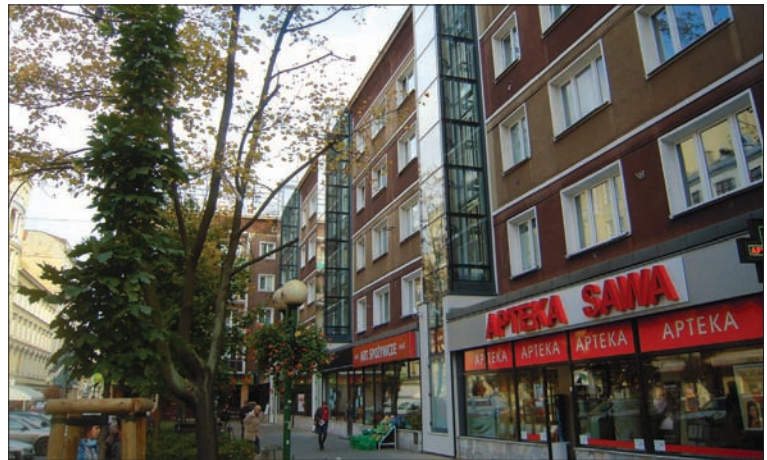
Chmielna - blok mieszkalny z dodanymi windami zewnętrznymi.
