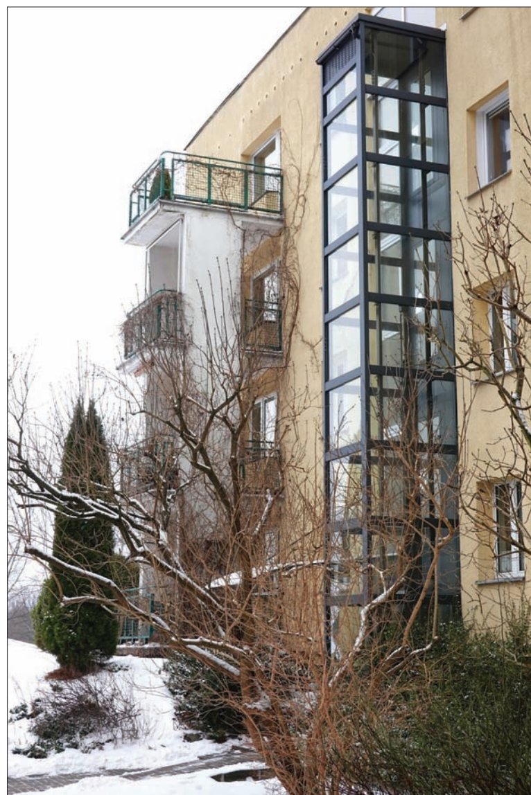
Zewnętrzna winda w bloku przy ul. Nutki na Ursynowie.
