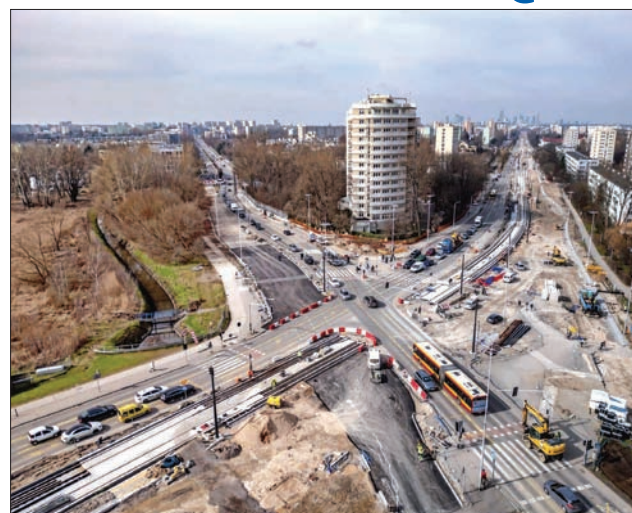
Budowa trasy tramwajowej do Wilanowa.
