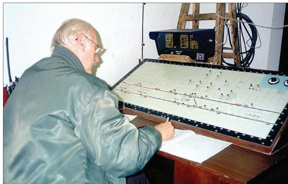
Zdjęcie z 19 czerwca 1993 r. przedstawia pulpity nastawczy w pomieszczeniu dyżurnego stacji A4 Stokłosy. Obowiązki dyżurnego ruchu pełnił inż. Andrzej Zajączkowski, ówczesny kierownik zespołu ds. automatyki sterowania metrem. Próbné jazdy odbywały się na trasie Kabaty - Stokłosy.
