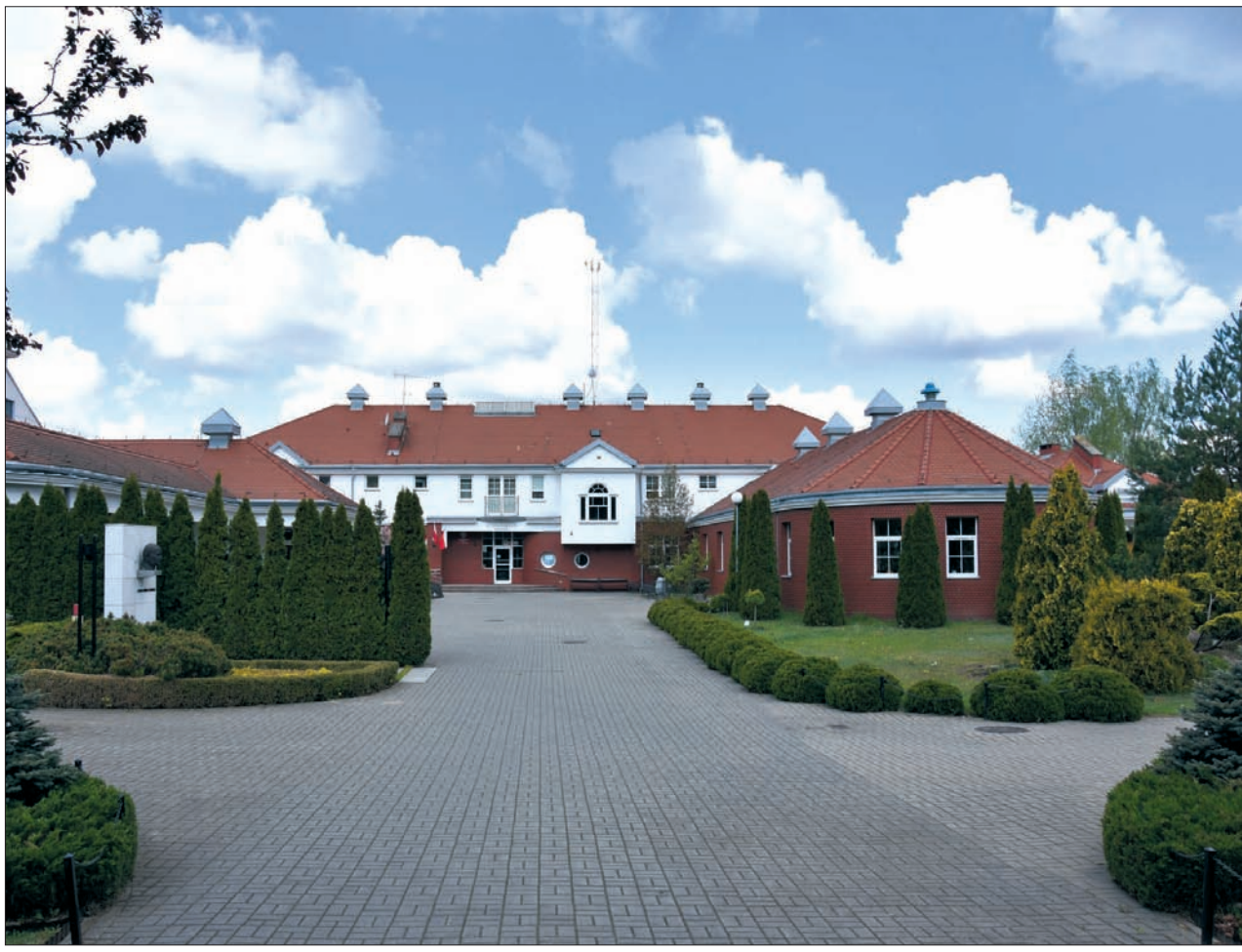
Szkoła Podstawowa w Łazach budynek przy ul. Słojewskiego.
