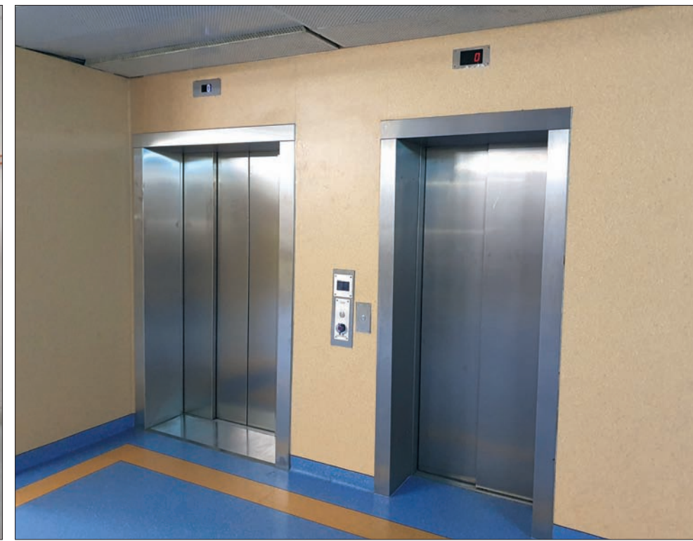
Wymiana sześciu dźwigów w szpitalu na Banacha, wyposażonych w najnowszej generacji urządzenia.
