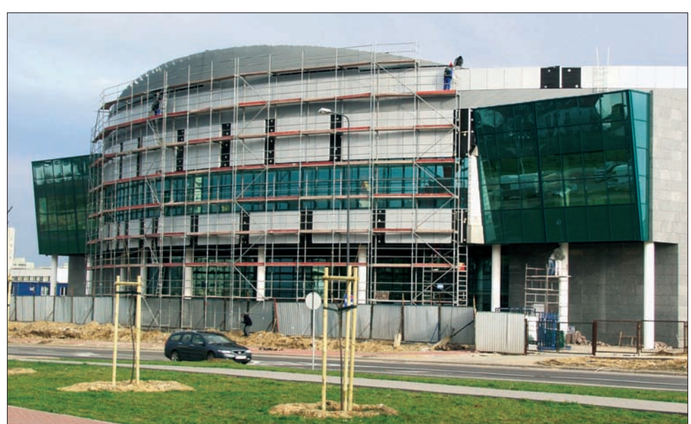
Budowa hali widowiskowo-sportowej Arena Ursynów, 2005 r.
