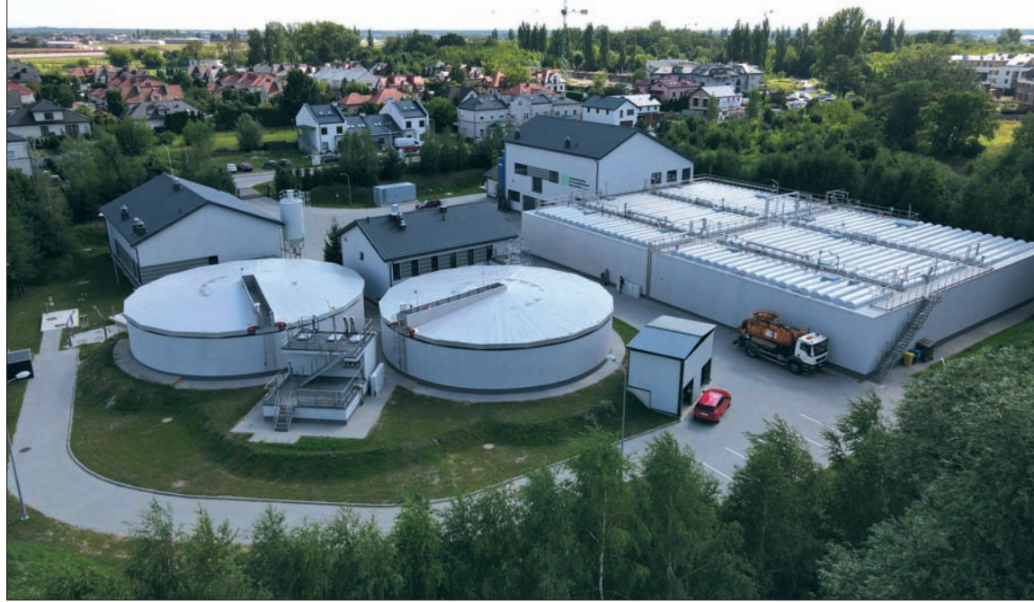
Oczyszczalnia ścieków w Zamieniu po rozbudowie.
